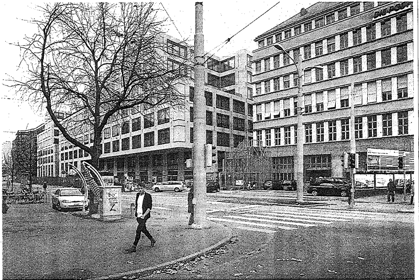
Der neue Campus Sihlhof (1.) bei der Sihlpost. Hier wird die Pädagogische Hochschule einziehen. Fotos: Dominique Meienberg (2), PD (3)
